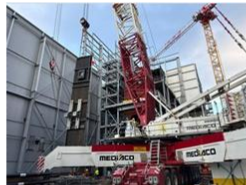
Montage du nouveau four-chaudière
