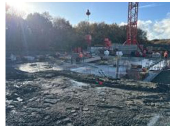
Coulage de la dalle et des voiles béton pour le bâtiment de la nouvelle turbine
