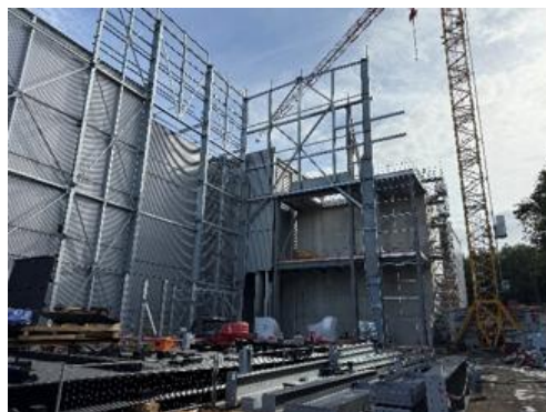
Montage de la structure pour le nouveau four-chaudière
