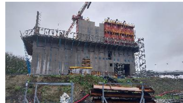
Coulage de la dalle et des voiles béton pour le bâtiment de la nouvelle turbine
