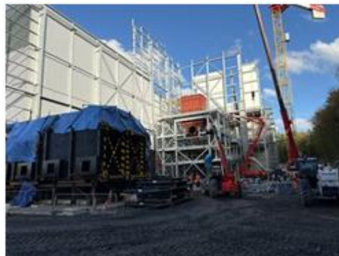
Montage de la structure pour le nouveau four-chaudière
