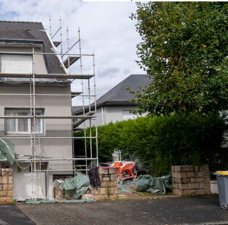
Travaux d'isolation par l'extérieur d'une maison individuelle.
