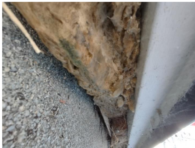
Composition du bardage a un endroit ou la bavette était manquante
