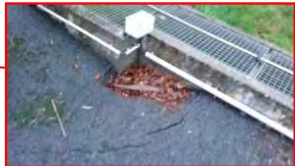
Affaissement de la voirie au niveau du canal de comptage sortie station (débordemens du canal de comptage)
