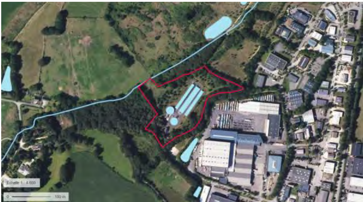
Figure 35: Vue aérienne du site d'implantation
