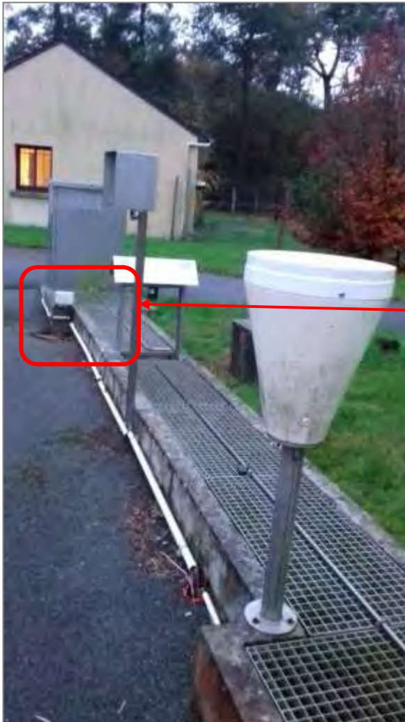
Affaissement de la voirie au niveau du canal de comptage sortie station (débordemens du canal de comptage)
