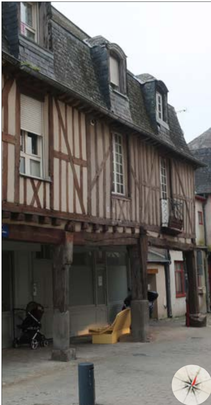
Exemple d'une maison à porche rue du Cheval-Blanc [Chroniques Conseil, 2023].
