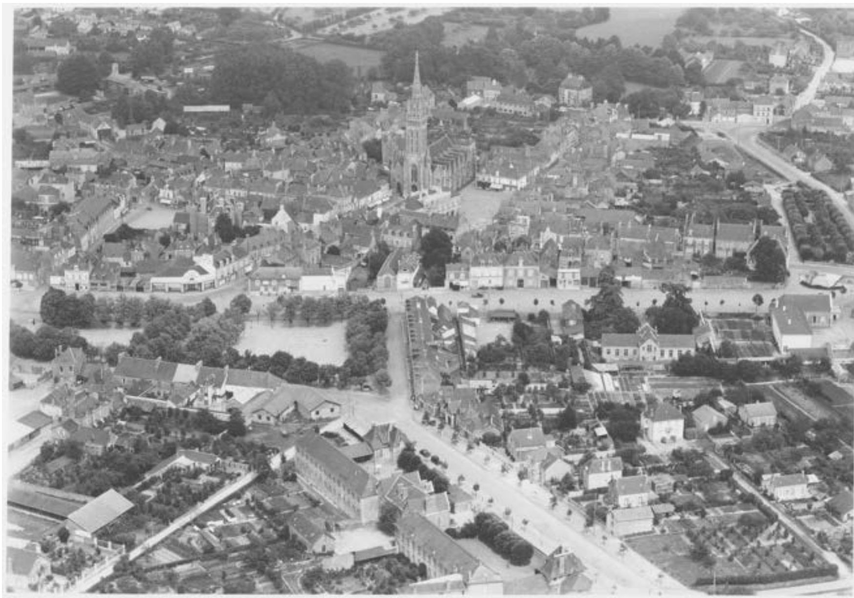
Vue aérienne entre 1945 et 1975, AP35HN0148, © ministère de la Culture (France), Base Mémoire, Photographe Roger Henrard
