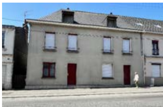
« Banalisation » d'une façade
