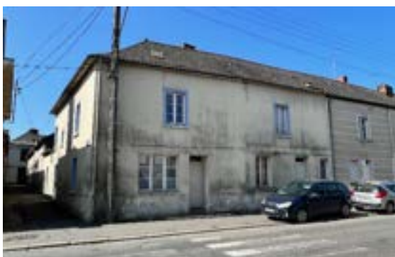
Probable structure pan de bois « cachée »
