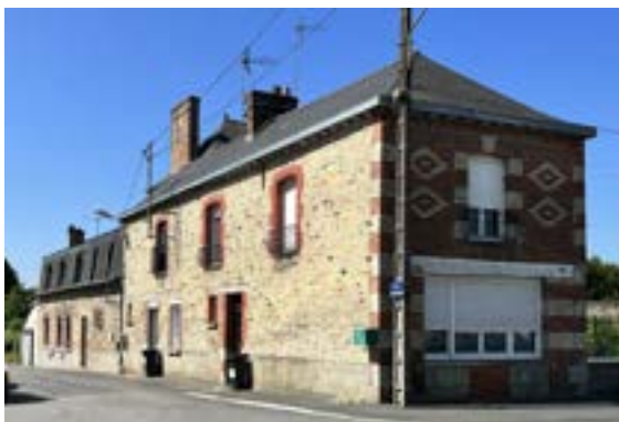
« Eventrement » des rez-de-chaussée
