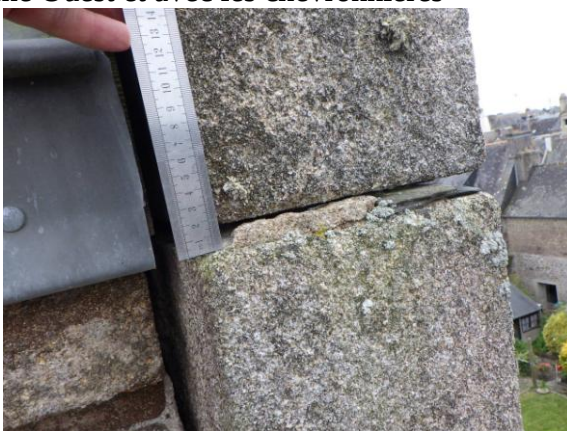
Disjonctions au niveau de la corniche Ouest et avec les chevronnières
