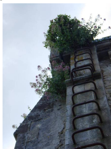
Contreforts Sud, décrochements d'enduits, mouvements structurels des contreforts, végétations
