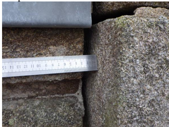
Disjonctions au niveau de la corniche Ouest et avec les chevronnières
