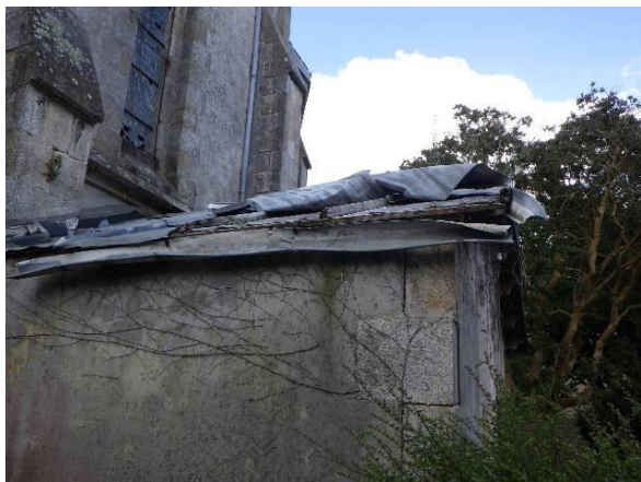
La couverture de la sacristie est partiellement arrachée
