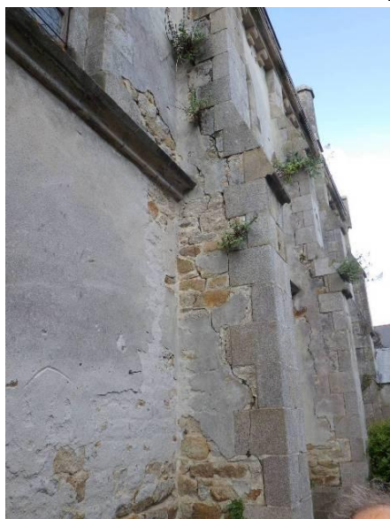
Contreforts Sud, décrochements d'enduits, mouvements structurels des contreforts, végétations
