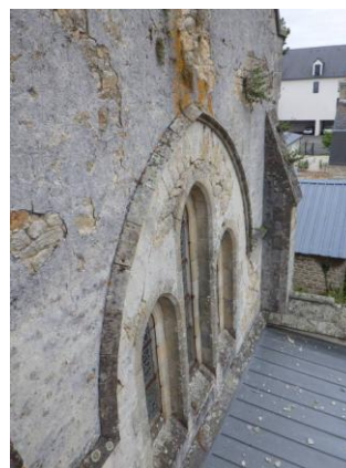
Chutes d'enduits sur le toit du narthex
