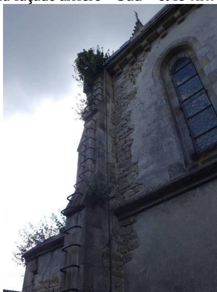
Contreforts Sud, décrochements d'enduits, mouvements structurels des contreforts, végétations
