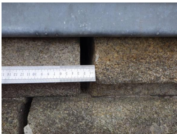
Disjonctions au niveau de la corniche Ouest et avec les chevronnières
