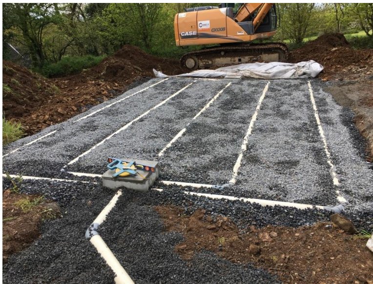
Exemple de dispositif de Traitement par filtre à sable vertical non drainé
