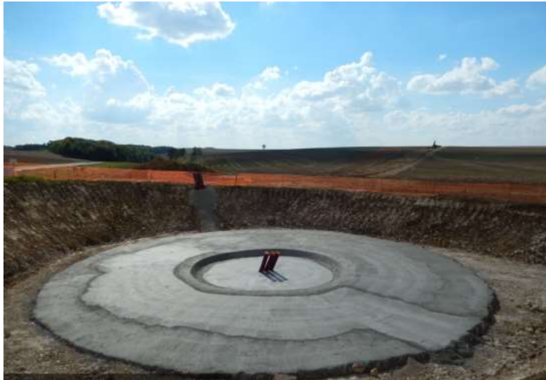
Photo 9 : Béton de propreté
