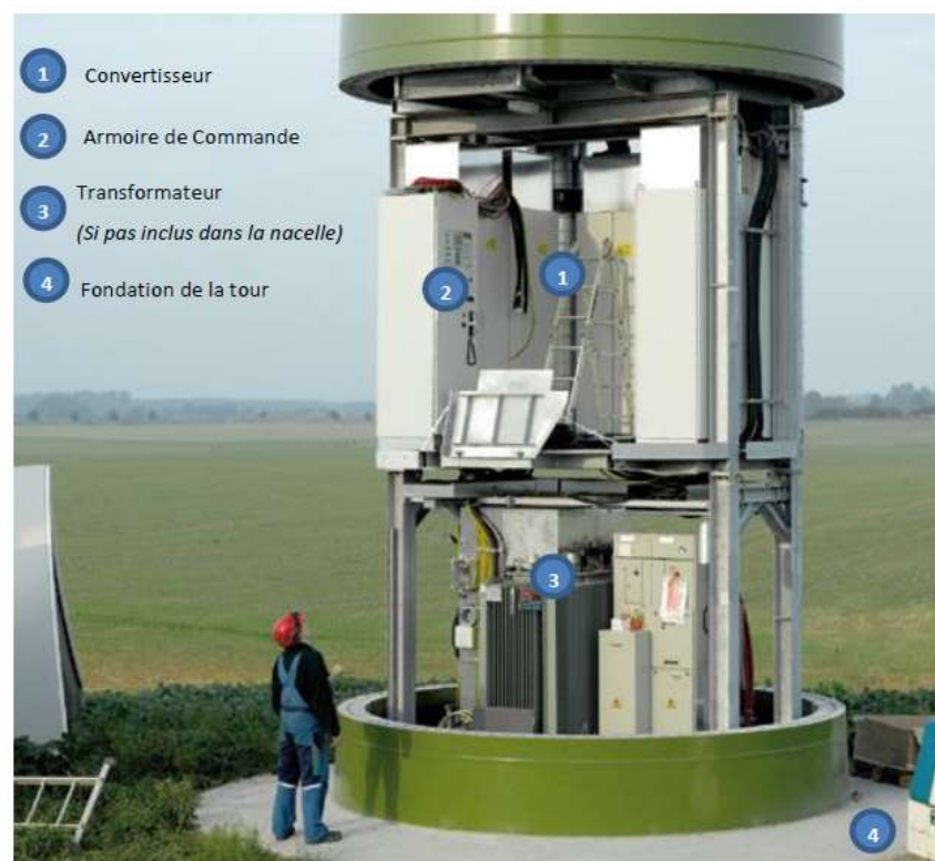
Illustration 1 : Transformateur inséré dans le mât (Enercon)
