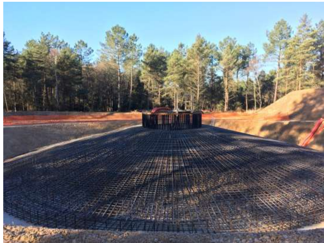
Photo 10 : Ferrailage
