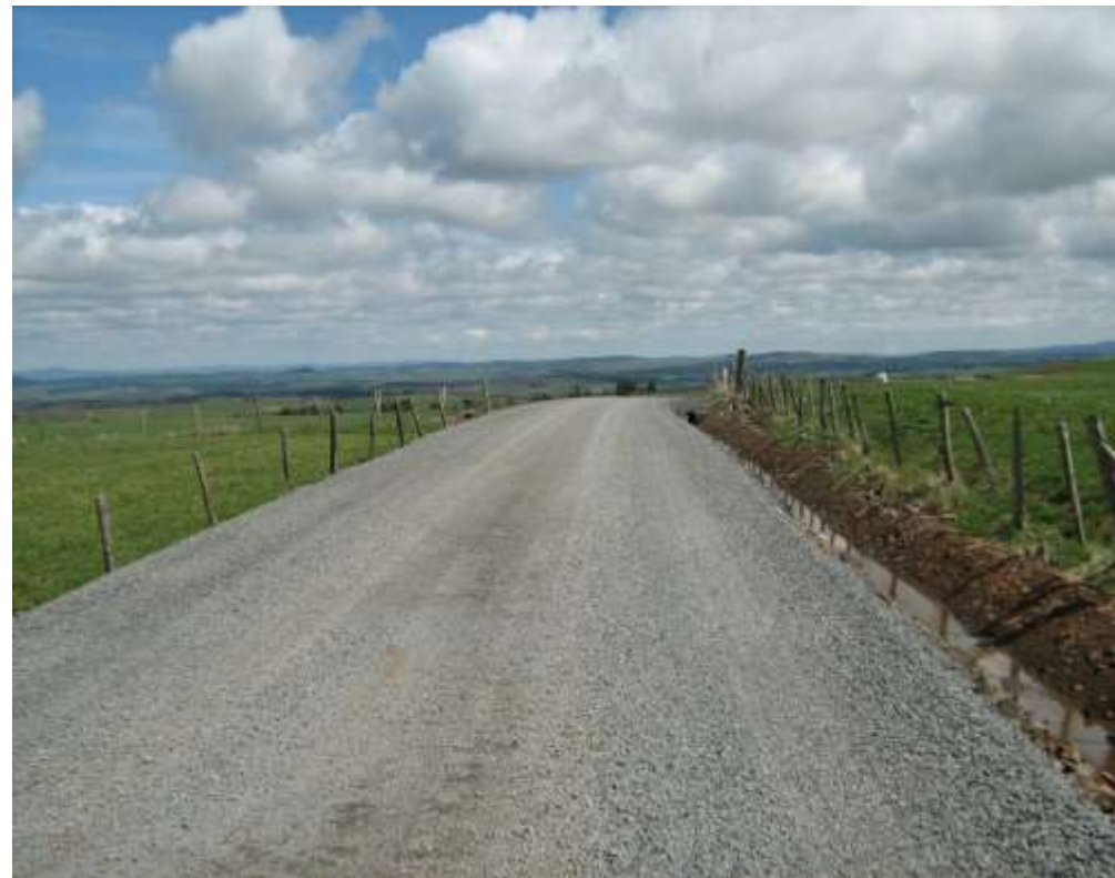
Photo 7 : Voie d'accès terminée
