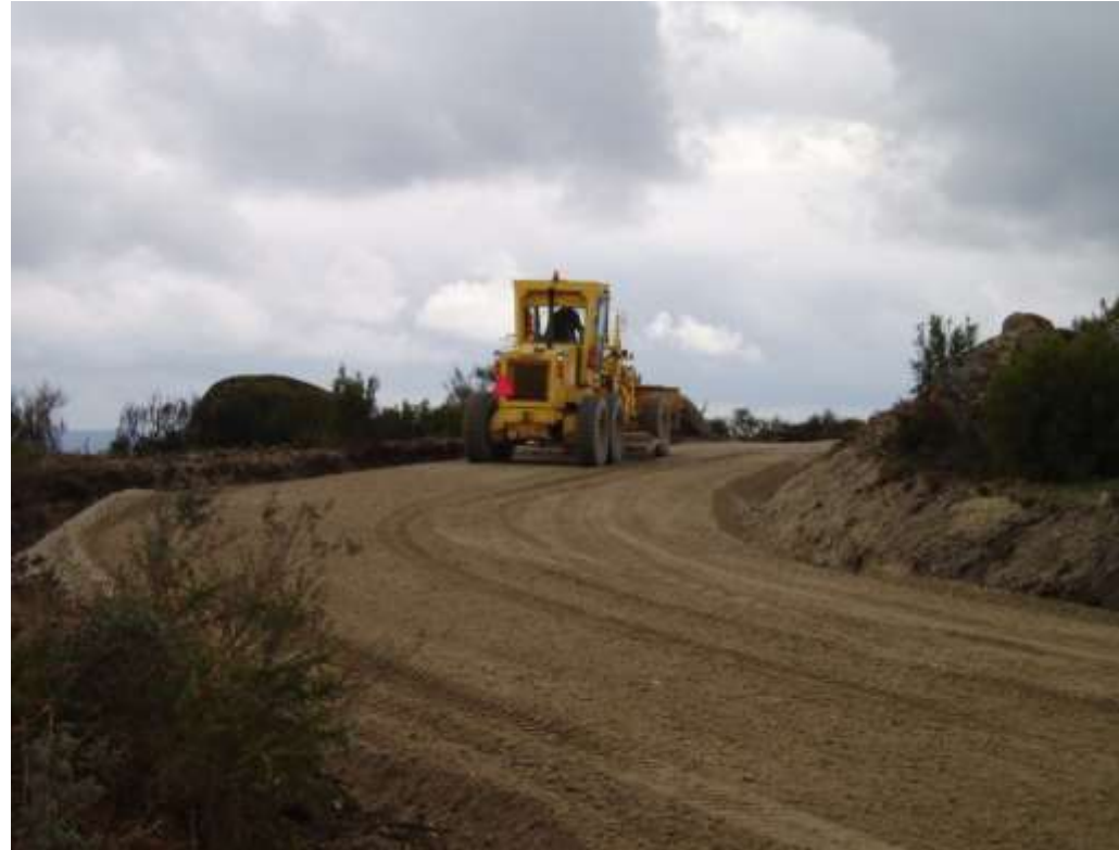
Photo 6 : Nivellement
