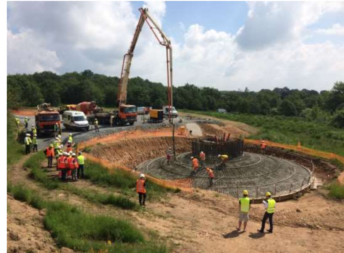
Photo 11 : Coulage du béton
