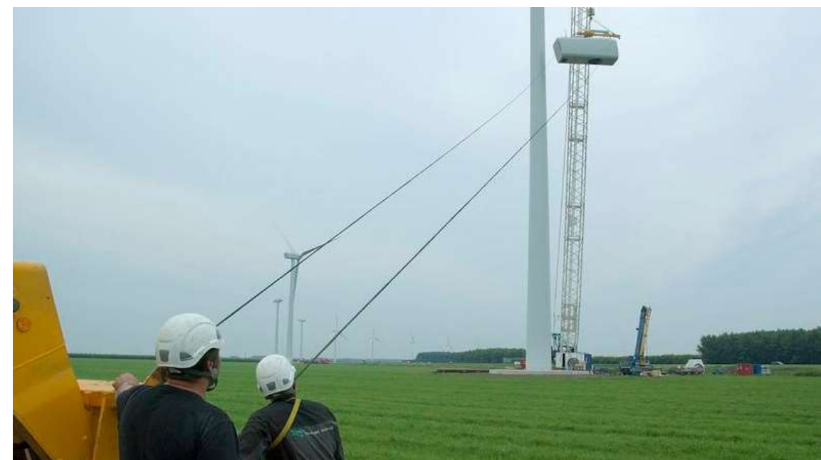
Photo 22 : Montage de la nacelle
