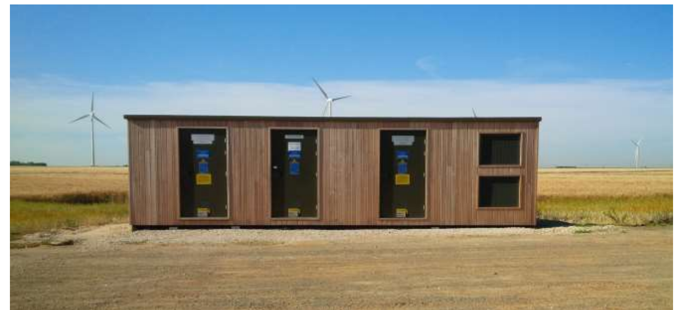
Photo 2 : Exemple d'un poste de livraison
