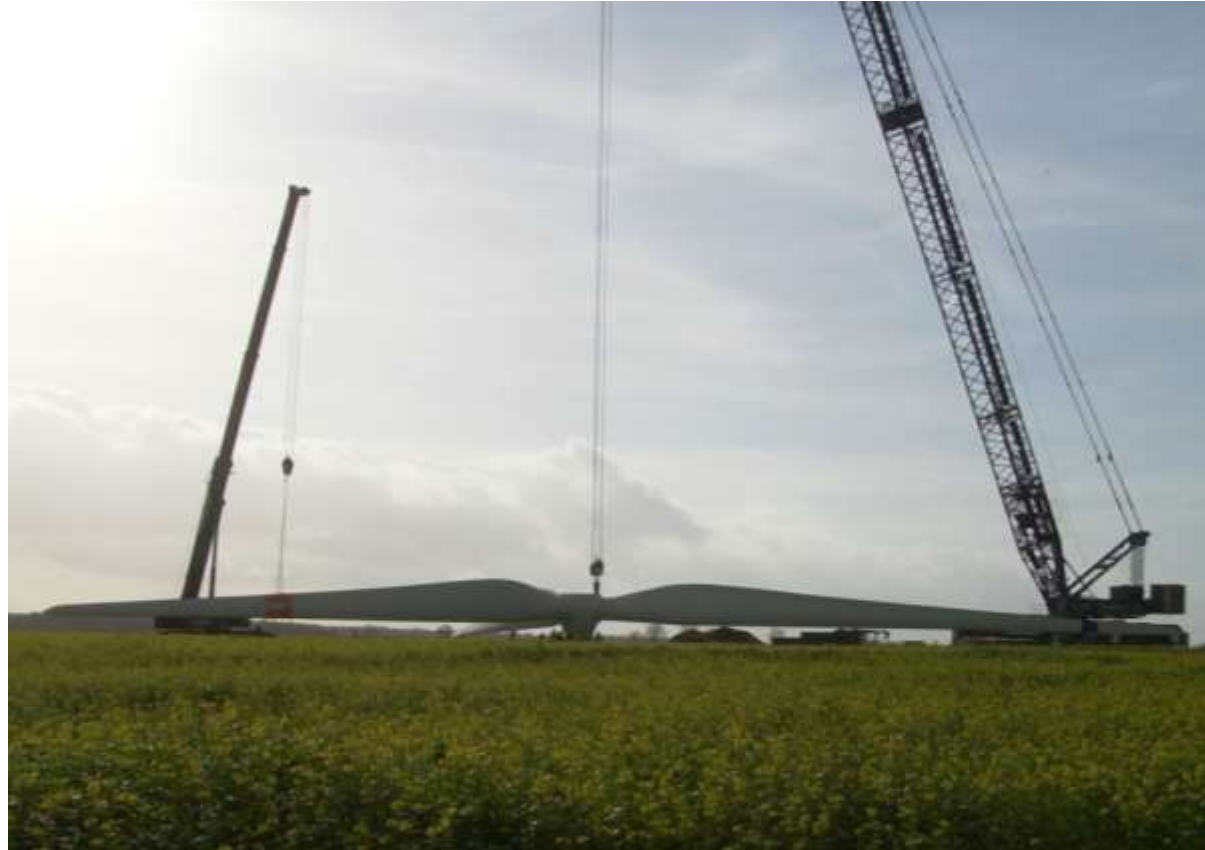
Photo 23 : Assemblage du rotor au sol
