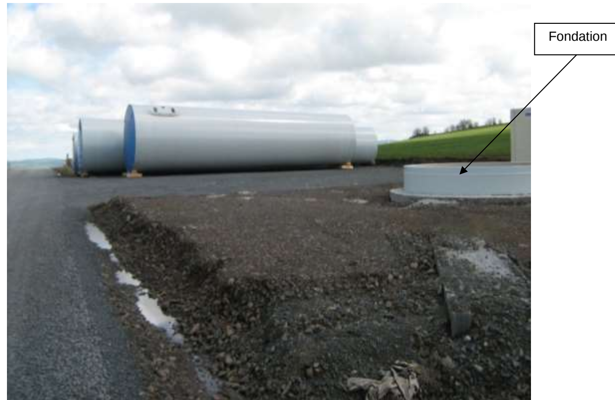
Photo 20 : Stockage des éléments de l'éolienne sur la plateforme à proximité de la fondation
