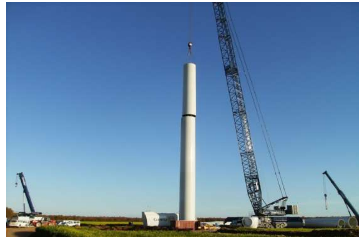
Photo 21 : Montage des éléments de la tour
