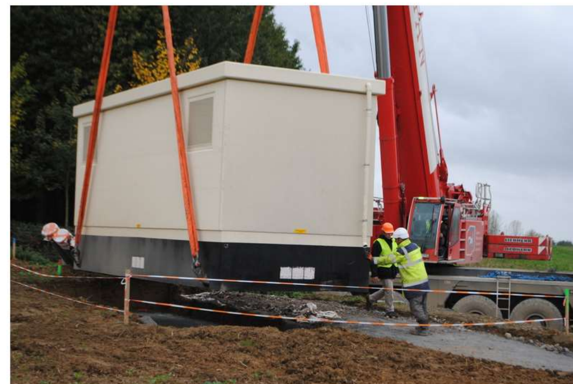
Photo 16 : Pose d'un poste de livraison
