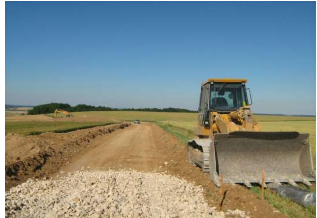
Photo 4 : Décapage du sol
