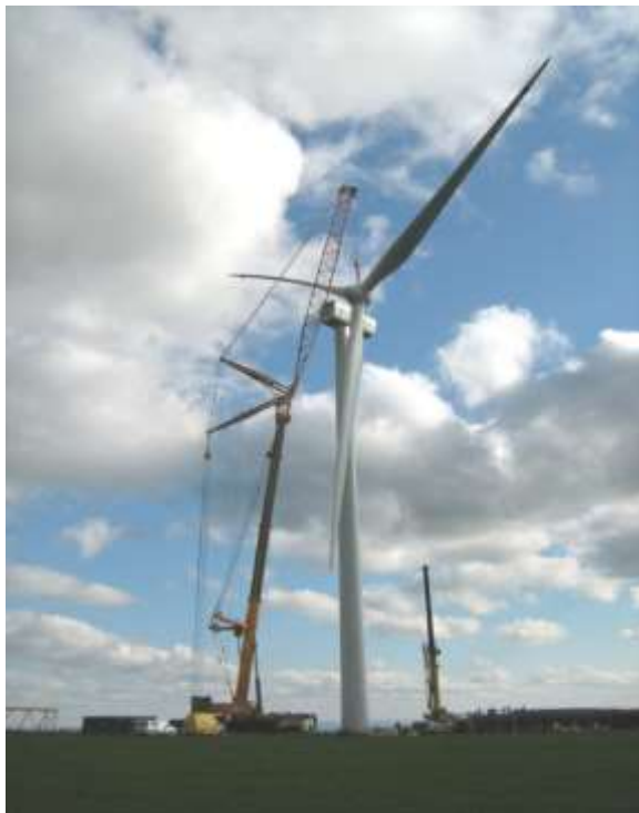
Photo 24 : Montage du rotor
