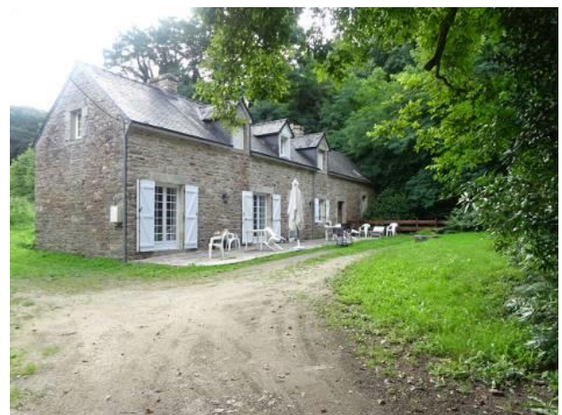
Ancien moulin du le Saint-Laurent. Il conserve son bien et sa chambre des meules.
