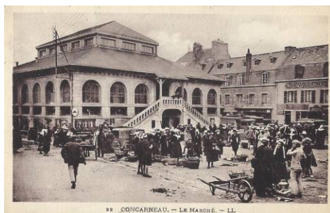
La halle construite en 1893 et complétée d'un étage en 1921.
