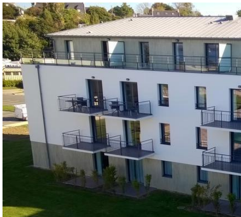
Le complexe hôtelier Thalasso Concarneau propose également 50 appartements locatifs en R+2 + combles
