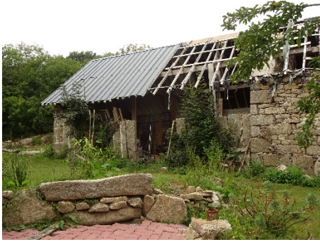
Mur bâti en orthostates (pierres debout en granite) à Kerambars.
