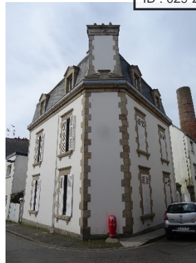
13, rue Bayard. Toiture à brisis et terrasson. 1904.
