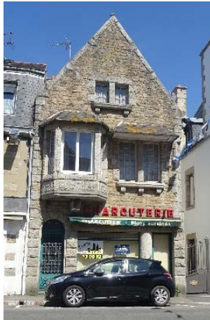
6, rue de la Gare. Maison à façade pignon néobretone. Vers 1920.
