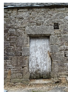
Porte à encadrement chanfreiné sous linteau monolithe daté de 1737. Maison élémentaire à Roz Bihan.
