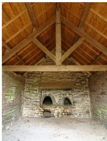
Four à pain à double cul-de-four. Manoir de Langoat.
