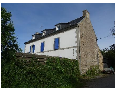
Le Questel. Maison à façade tripartite, vers 1900. L'enduit de la façade renforce la composition symétrique.
