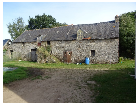
Le Questel. Grange-étable à escalier extérieur en pierre.
