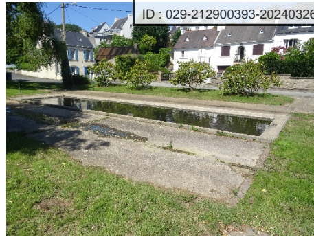
Le lavoir Saint-Jacques, rue des Chênes. Ne subsiste que le bassin bétonné.
