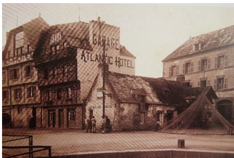
Petite maison contre le garage de l'Atlantic Hôtel au sud du bassin Pénéroff. Dans Belser.
