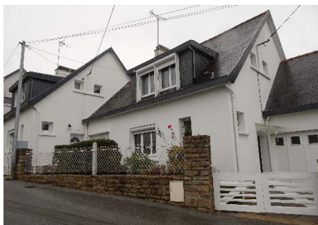
Maisons du Dorlett, rue des Fleurs. Un mur-bahut accompagné d'une simple grille inclut les piliers du portail.
