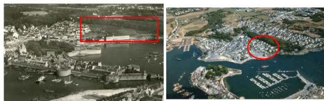
La Cité des Pins. A gauche, l'emprise à lotir en 1954. A droite, la Cité des Pins. AC, 23 Fi 118, 23 Fi 662.
