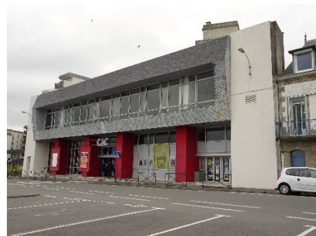
L'ancienne usine Bouvais-Flon.
