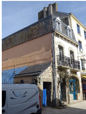
Ville-Close. Rue Vauban. Toiture à brisis et terrasson.
