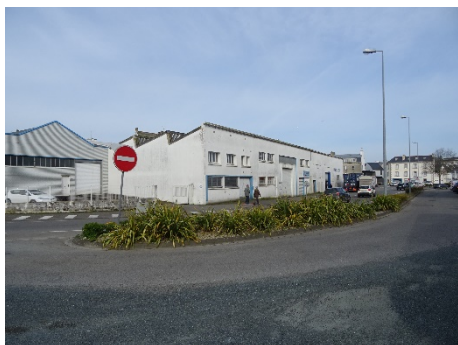
9, rue du Docteur Legendre. Angle avec le quai Carnot. Bâtiment industriel à sheds.
