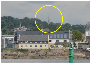
L'église Saint-Budoc de Beuzec dotée d'un phare d'alignement pour l'entrée dans le chenal du port
