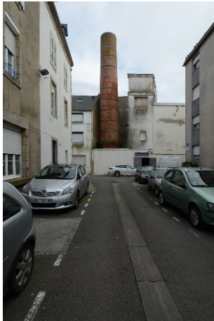
La cheminée de l'usine Bouvais-Flon.
