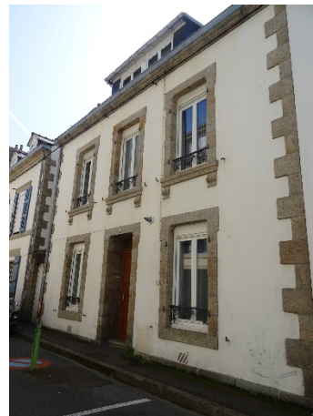
43, rue Jean Bart. Parement en maçonnerie moellonnée enduite. Encadrements de baies, chaînes d'angle et corniche en granite.
