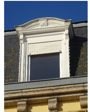
7, avenue du Docteur Pierre Nicolas. Corniche sur modillons et lucarnes à fronton de bois curviligne.
