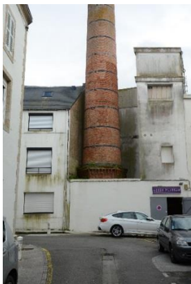
Cheminée de l'ancienne usine Beauvais-Flon (1917). Elle fut érigée par l'entrepreneur Bonduelle. L'usine a fermé ses portes en 1959.
