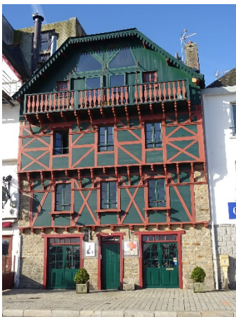
22, avenue du Docteur Pierre Nicolas Maison d'inspiration norvégienne construite en 1885 par Etienne Guillou, pilote du port.
