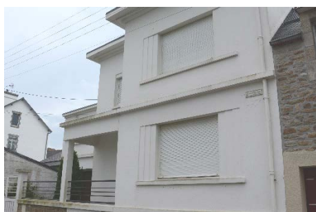
29, rue Lucien Hascoët. Jacques Deyrolle, architecte. Vers 1930 – 1940 ?
