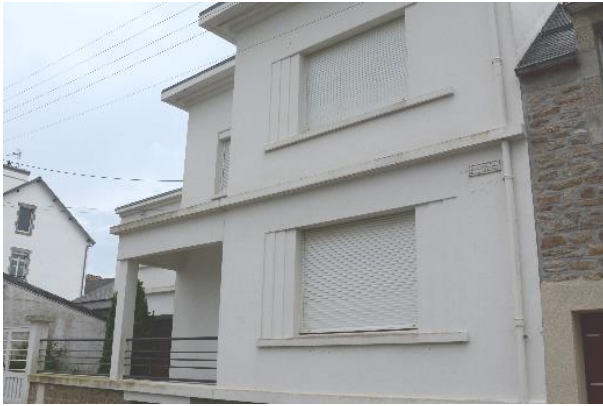
29, rue Lucien Hascoët. Jacques Deyrolle, architecte. Vers 1930 - 1940 ?
