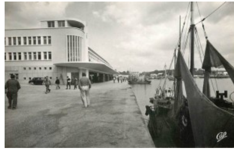
La criée, quai au Lin. Vers 1960 avant l'installation de l'extension.
