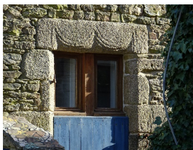
Porte sous linteau en arc en accolade. 17 e siècle ? Le Penquer.
