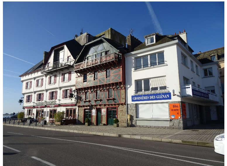
Avenue du Docteur Pierre Nicolas. La maison Guillou-Deyrolle est cantonnée par un immeuble des années 1960.
