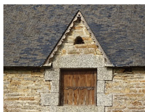
Lucarne passante à fronton triangulaire. Début 20 e siècle. Grange-étable à Kerhuel.
