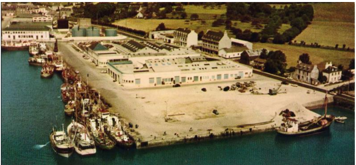
Extension du Quai Est
