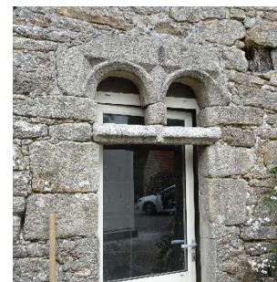
Fenêtre à meneau du 17 e siècle transformée en porte. Roz Bihan.
