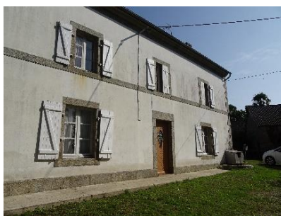
Coat-Conq. Façade tripartite enduite. Le cordon de pierre filant sur toute la longueur de la façade participe à cette typologie.
