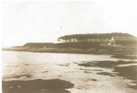
Les vestiges de la batterie de Beuzec. Photographie du début du 20 e siècle. Dans Ribouchon, p. 173.
