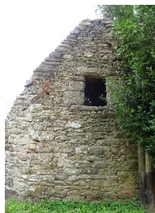
Jour en encadrement chanfreiné. 17 e siècle ? Pignon d'une grange-étable au Mégot.
