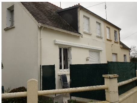
Le lotissement du Pontic, rue du Pontic, 1949
