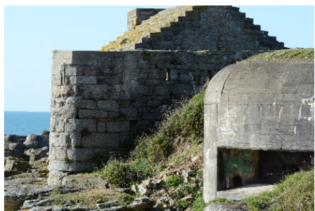
Blockhaus au fort du Cabellou.
