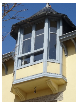
Place de la Croix. Bow-window en structure bois.
