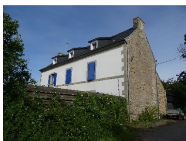
Le Questel. Maison à façade tripartite, vers 1900. L'enduit de la façade renforce la composition symétrique.
