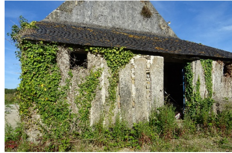
Petite dépendance (soue à cochon ?) adossée à une ferme. Entre les pierres debout, blocage en moellons.
