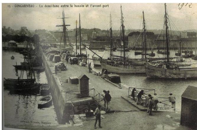
La demi-lune entre le bassin et l'avant-port
