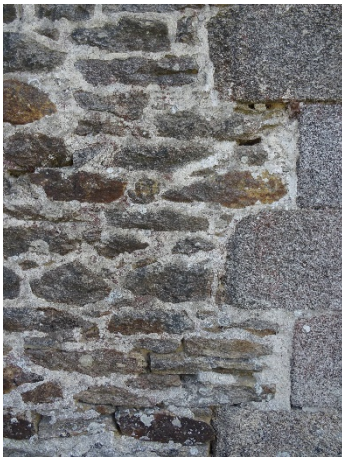
Grange. Parement de mur en moellons de micaschiste et encadrement de porte en blocs de granite. Lochrist.
