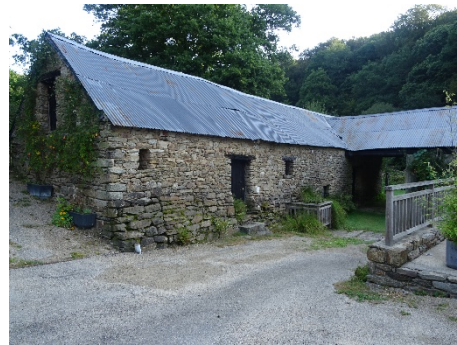
Dépendance de l'ancien moulin de La Haie.
