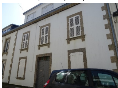
45 rue Jean Bart. Façade tripartite.
