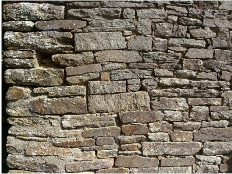
Parement de mur en moellons de micaschiste. Lochrist.
