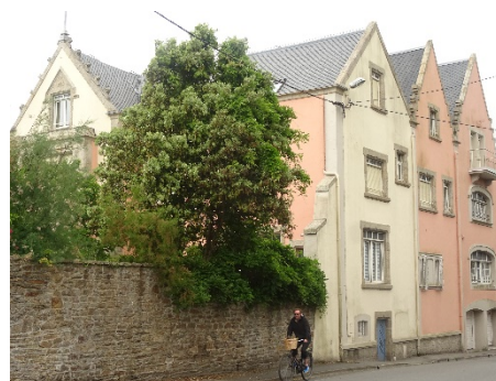
Villa Les Haudriettes. 1891. Edifiée par le comte de Chauveau. 39, boulevard Alfred Guillou. Style néogothique.
