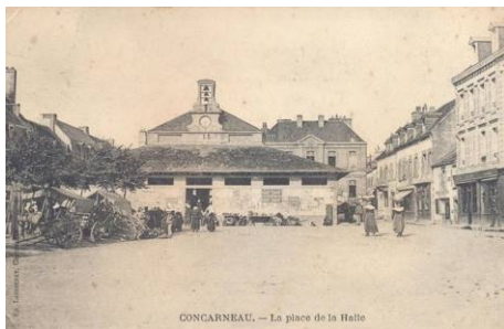
La halle construite en 1855 agrémenté d'une horloge en 1864.
