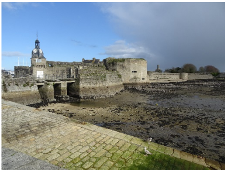
L'entrée : les deux ponts et le Ravelin précédant la demi-lune.
