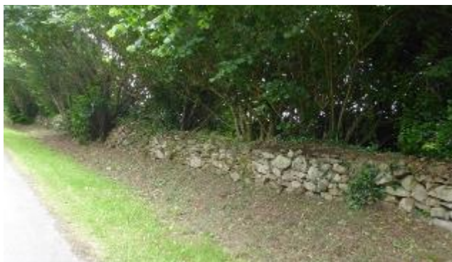
Talus en pierre aux abords de Kersaby
