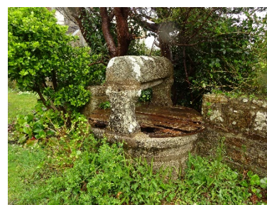
Kerambars. Margelle circulaire et potence en pierre. 19 e siècle.
