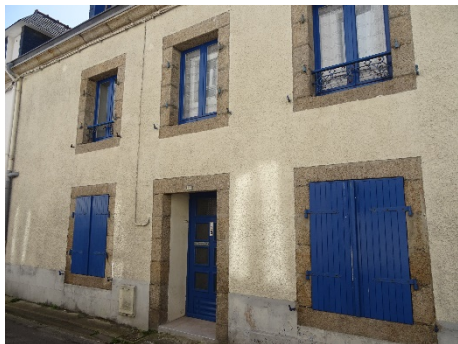
15, rue Jean Bart. Façade tripartite.
