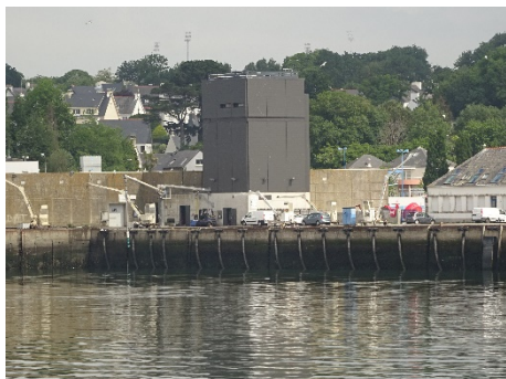
Le silo à glace édifié en 2011.
