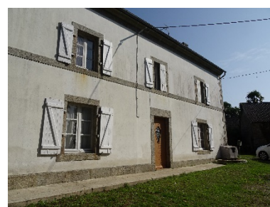
Coat-Conq. Façade tripartite enduite. Le cordon de pierre filant sur toute la longueur de la façade participe à cette typologie.
