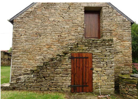
Le Questel. Grange-étable à escalier extérieur en pierre.
