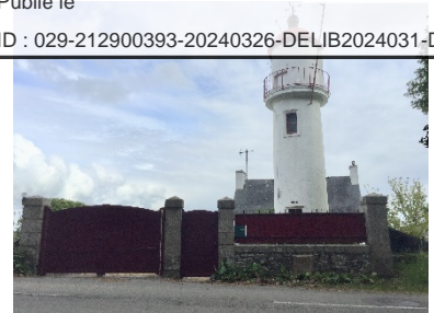
Phare de Kériolet, 1848 (entrepreneur : Raboisson). Phare hors service, remplacé par le phare du clocher de l'église de Beuzec. Dans l'alignement de la balise du Cochon et du phare de la Croix, il donnait l'axe du cheval d'entrée au port.
