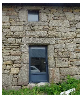
Porte à encadrement rectangulaire aux angles chanfreinés surmontée d'un jour rectangulaire. 17 e siècle ? Petite maison élémentaire au Mégot.
