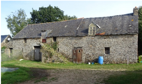
Le Questel. Petite maison et grange-étable contiguë au grenier accessible par un escalier extérieur en pierre.
