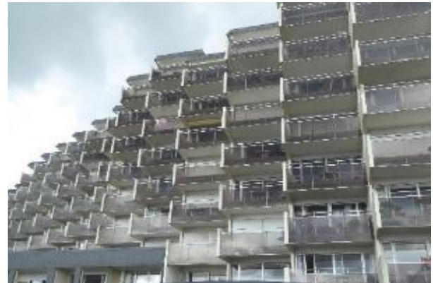
Immeubles à façade à balcon, hors d'échelle, Boulevard Bougainville, quartier Coat-Pin
