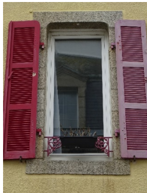
24, rue Dumont d'Urville. Linteau à adoucissement semi-circulaire.
