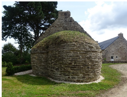
Four à pain à double cul-de-four. Manoir de Langoat.
