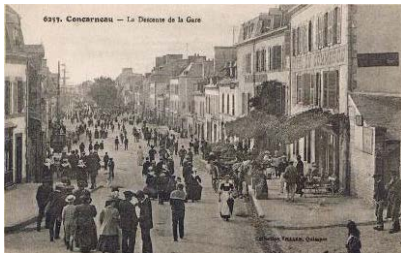
L'avenue de la Gare dans le prolongement de l'avenue Pierre Guéguin constitue l'extension nord de la ville dès la fin du 19 e siècle. Carte postale vers 1900.
