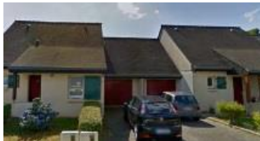
Coat Braz et la mitoyenneté par le garage en lotissement
