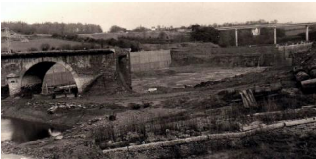
Le vieux pont est dynamité le 24 mars 1966
