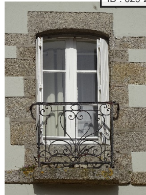
Ville-Close. Place Saint-Guérolé. 18 e siècle. Porte-fenêtre à linteau en arc segmentaire.
