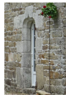
Porte chanfreinée sous arc déprimé clavé mouluré d'une accolade. 17 e siècle ? Maison rurale à Lanphily.
