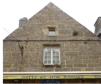
Parement en pierres de taille de granite. 17, rue Vauban.
