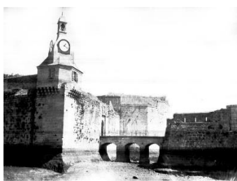
Les remparts de la Ville-Close
