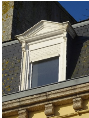
7, avenue du Docteur Pierre Nicolas. Corniche sur modillons et lucarnes à fronton de bois et consoles.
