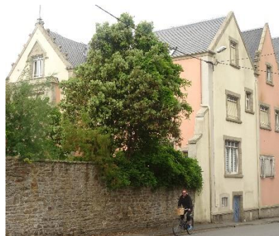
Villa Les Haudriettes. 1891. Edifiée par le comte de Chauveau. 39, boulevard Alfred Guillou. Style néogothique.
