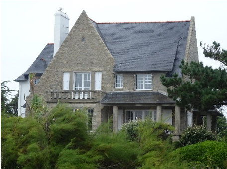
Lotissement du Cabellou. La villa « Les Roches claires » de Charles Le Boucq, 1926.
