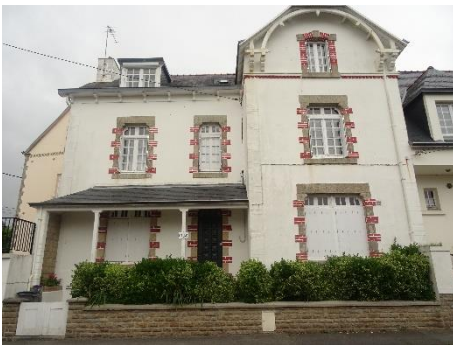
Villa Les Lilas, 36, boulevard Alfred Guillou. Villa en « faux L » de style néonormand.
