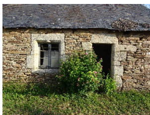
Fenêtre à croisée (seul reste le départ supérieur du meneau de pierre) et porte à encadrement rectangulaire à arêtes vives. 17 e siècle ? Petite maison élémentaire à La Haie.
