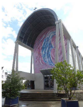
Eglise Saint-Guérolé. Architectes M. Galmiche et Erika Etasse.
